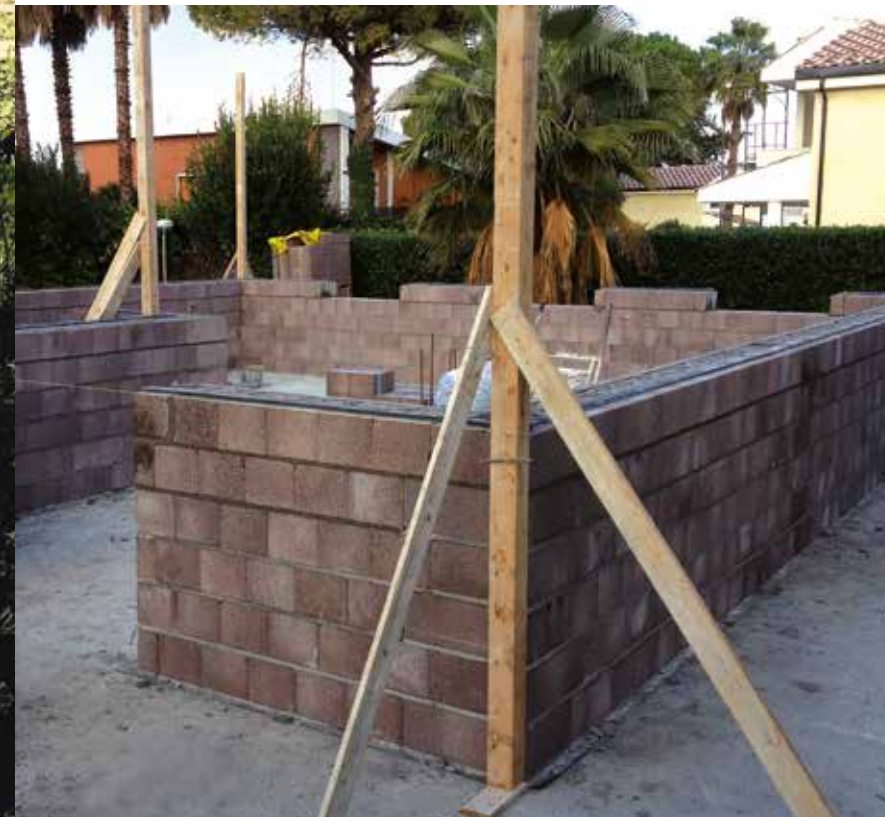
Muratura armata con Lecablocco Bioclima Zero 27p.
