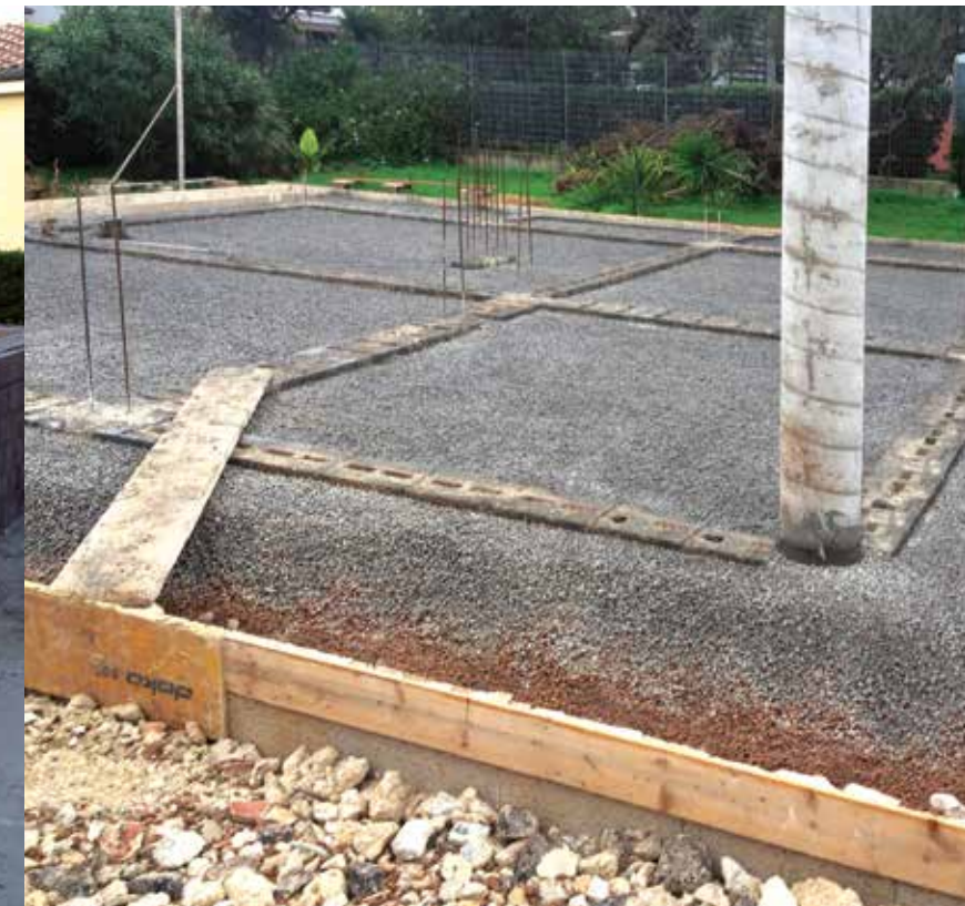
Vespai isolati controterra con argilla espansa Termopiù.
